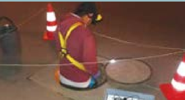
Entrada al colector
