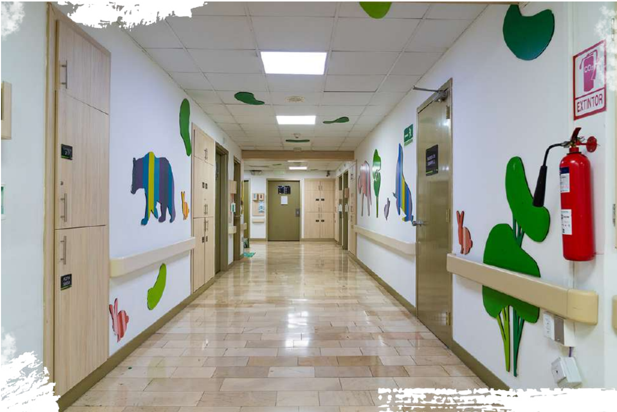
Sistema de calentamiento solar (arriba) e iluminación LED (abajo)
