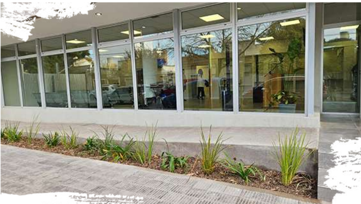
Imagen de una de las nuevas obras que se realizaron en el hospital.
