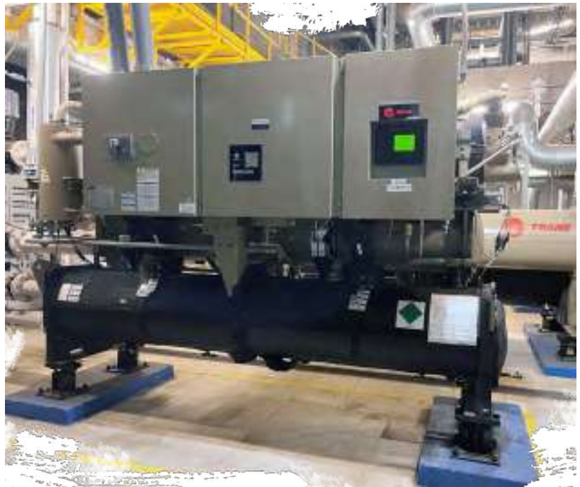
Escaleras mecánicas y bomba de calor.
