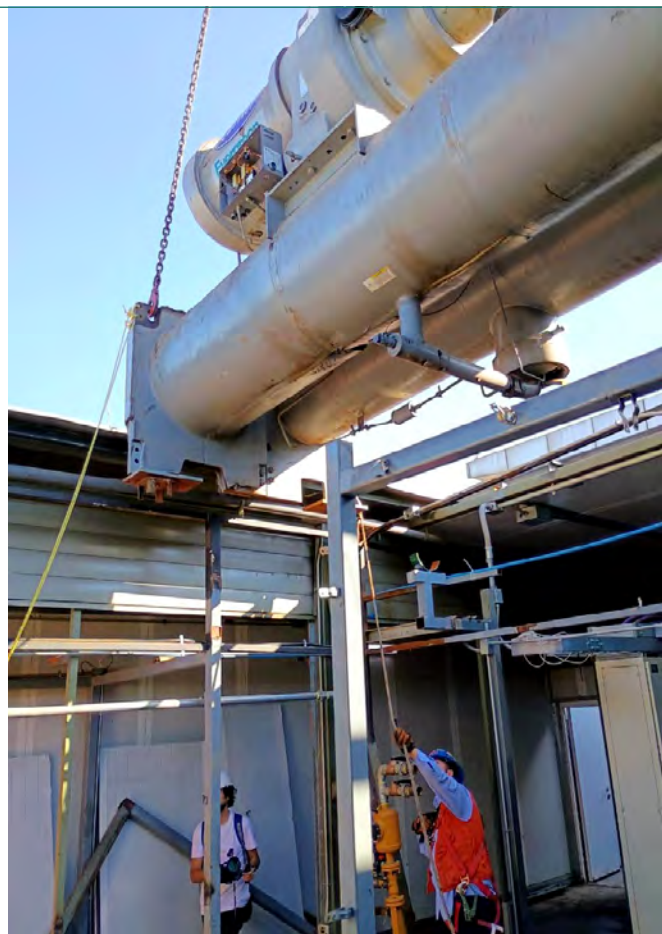
Proceso de renovación de los chillers
