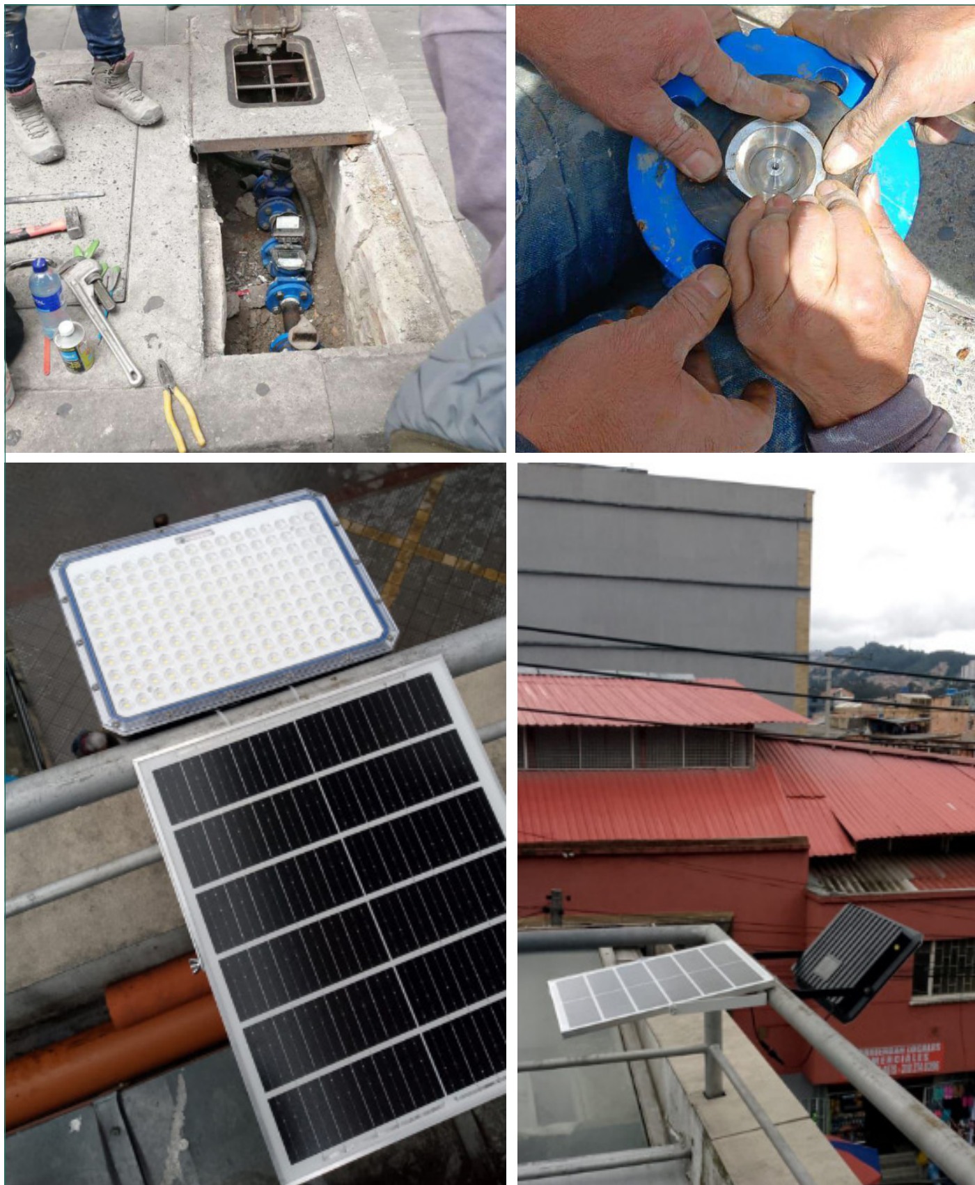
Dispositivo ahorrador de agua (arriba) y sistema de fotoceldas para alumbrado de urgencias (abajo)
